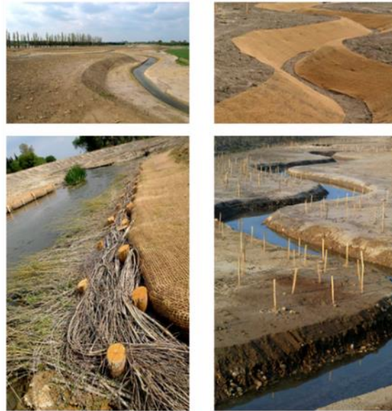
Figura 57: Imágenes referenciales acerca de la instalación de geotextiles biodegradables para la estabilización y restauración de riberas. Fuente: www.genie-ecologique.fr
