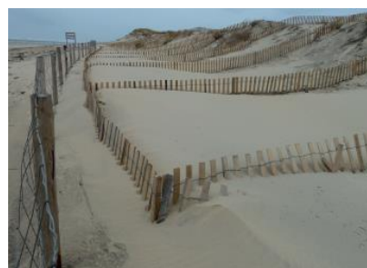
Figura 50: Ejemplo de estructuras corta viento para restaurar dunas. Arriba: detalles (elaboración propia). Abajo: estructuras de mimbre y madera en curvas de nivel (Gougnet 2018)
