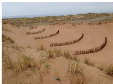
Figure 3.17. Fascines d'osier utilisées en Espagne. © L. Gougnet/ONE
