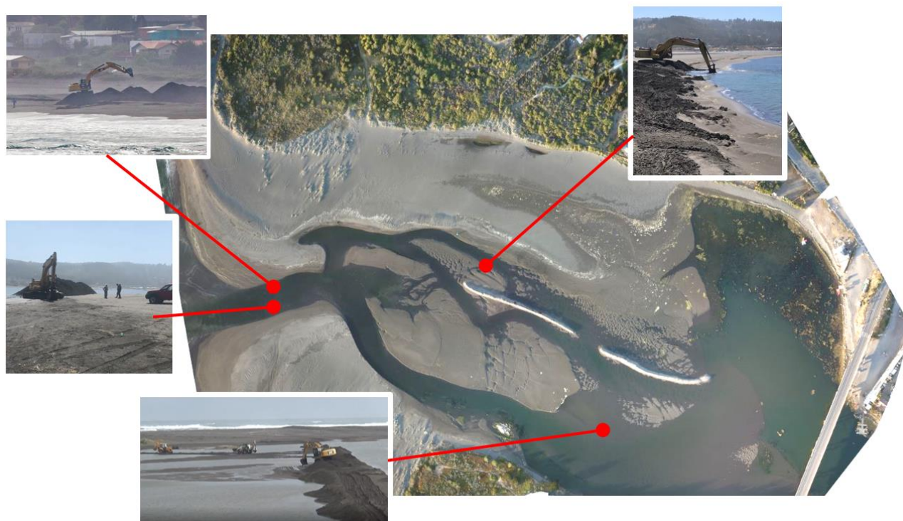
Figura 2 Fotografía mosaico de Cahuil (diciembre 2020), durante marea baja. Se aprecia el grado de embancamiento, y lugares donde se observaron maquinarias trabajando entre años 2020 y 2021.
