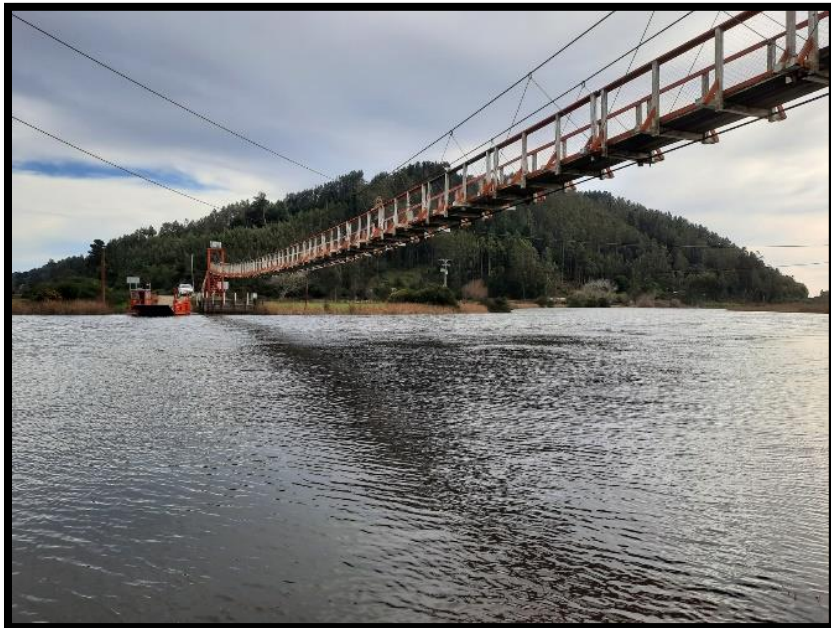
Figura 5. Estación de monitoreo Balsa Nigüe, mayo 2023.
