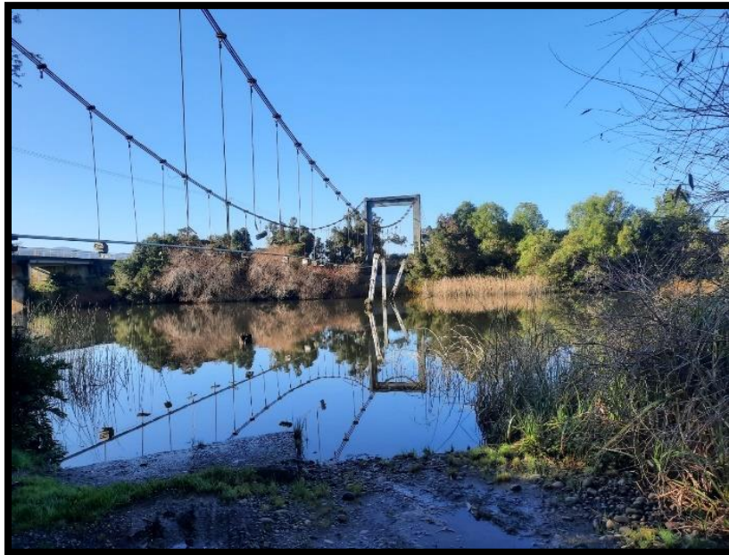
Figura 16. Estación de monitoreo Puente Boldo, mayo 2023.
