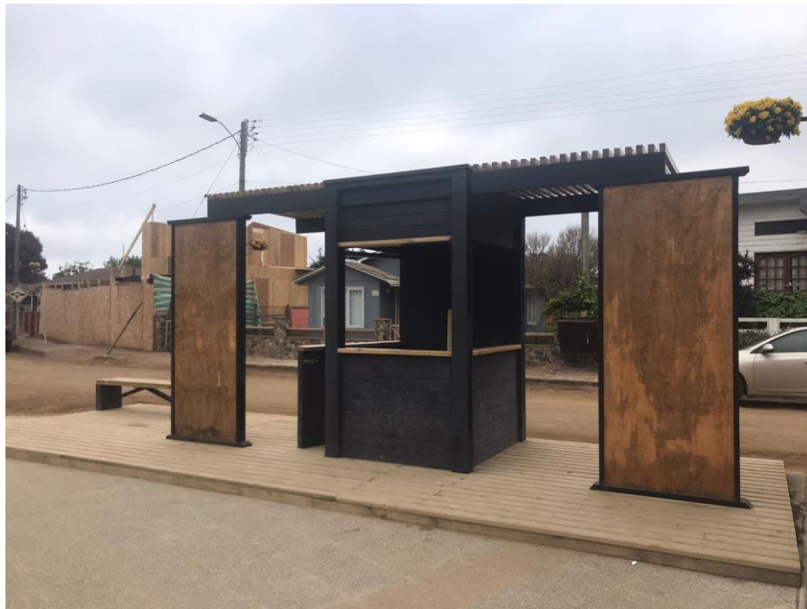
Figura 7-14. Caseta de guardaparque por la ribera norte del HU Laguna y Estero Catapilco (Foto: Photosintesis, 2022).
