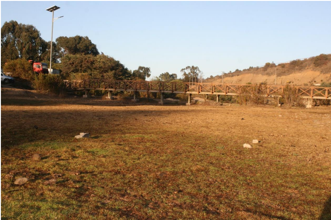
Figura 7-19. Puente peatonal Estero Catapilco en tramo Estero Catapilco (Foto: Photosíntesis, 2022).
