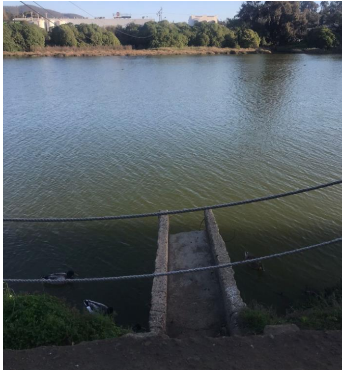
Figura 7-11. Canal de desagüe de aguas lluvia que desemboca en el HU Laguna y Estero Catapilco (Foto: Photosintesis, 2022).
