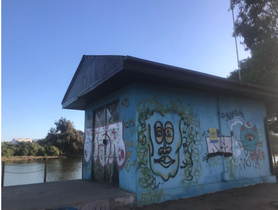
Figura 7-10. Caseta de la PEAS La Laguna de la empresa ESVAL (Foto: Photosintesis, 2022).
