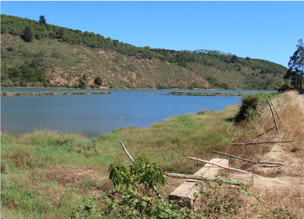
Alto nivel de agua y estero ancho en el sector km15,900.
