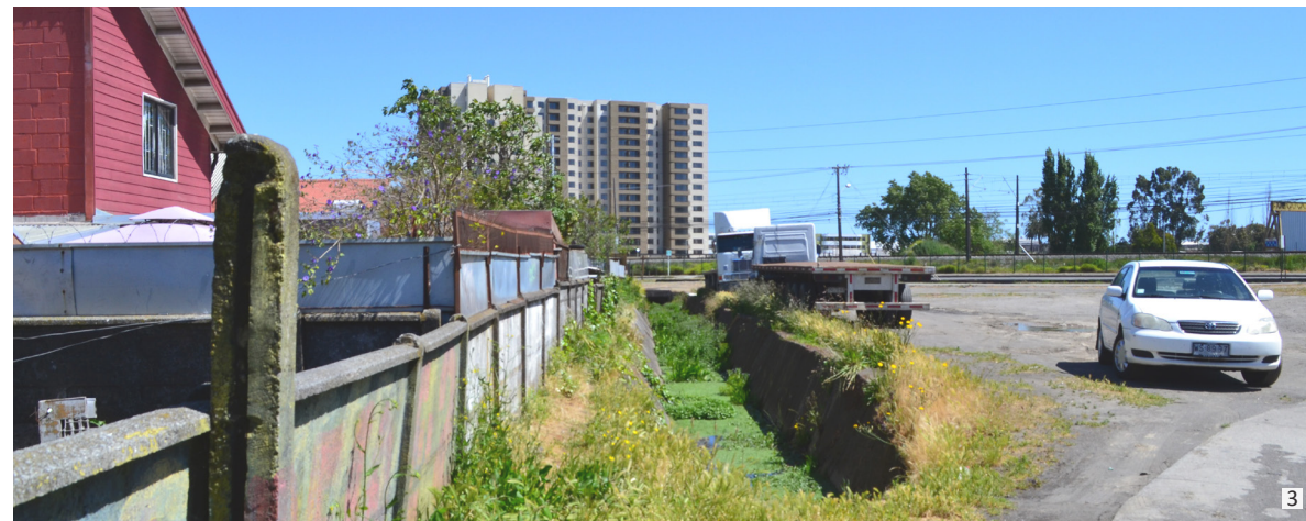
Fig.47: Impactos en el área de Paicavi - Vasco Da Gama. 1 Bordes, humedal-ciudad, en abandono; 2 Relleno en humedal; 3 Infraestructura para aguas lluvias en sectores aledaños del humedal. Autores: 1 y 3 Agurto y Espinosa, 2023; 2 Felis, 2023.
