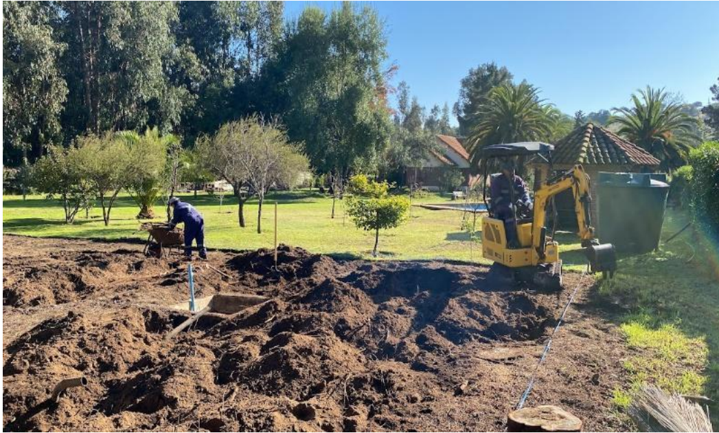
Foto 14. Descompactación del suelo con máquina.
