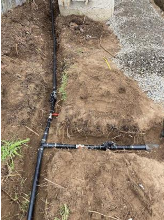
Foto 10 Instalación válvula 2 y válvula 3
