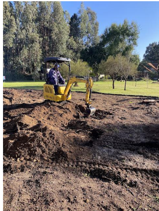
Foto 13. Descompactación suelo con máquina.
