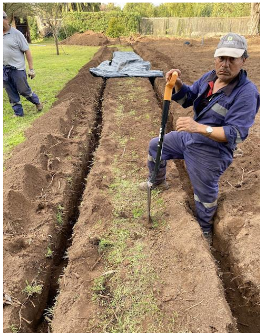
Foto 15. Instalación corchete malla antimaleza perimetral en el núcleo norte.
