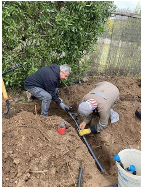
Foto 9 Instalación matriz de riego.
