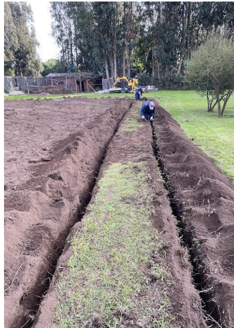
Foto 15. Instalación corchete malla antimaleza perimetral en el núcleo norte.
