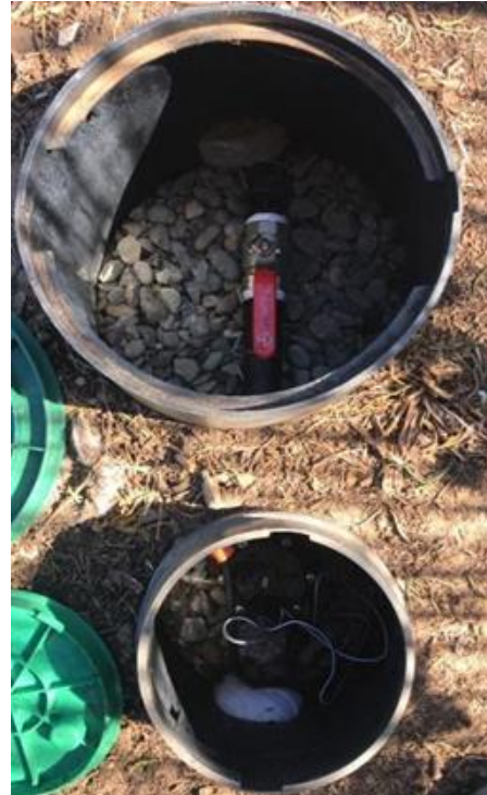
Foto 11 Caja guarda válvula
