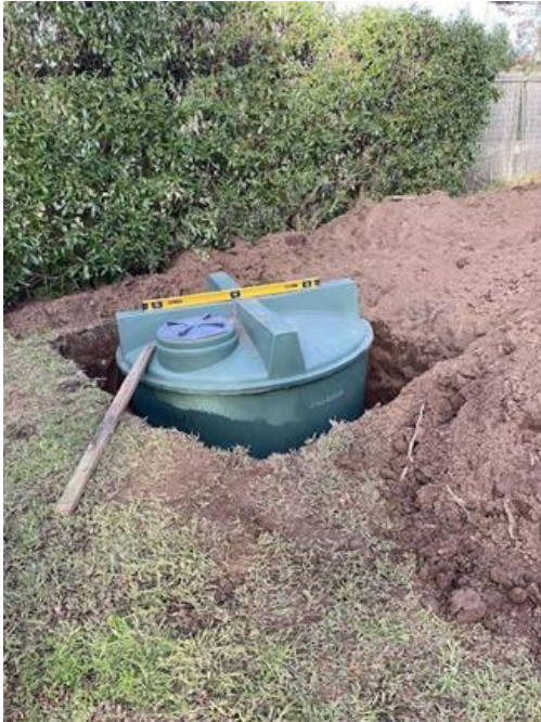
Foto 2 Estanque de riego enterrado.
