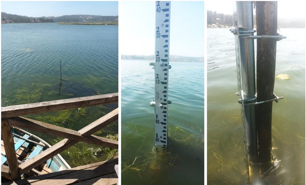
Figura 6 Instalación de regleta de nivel en sector Barrancas
