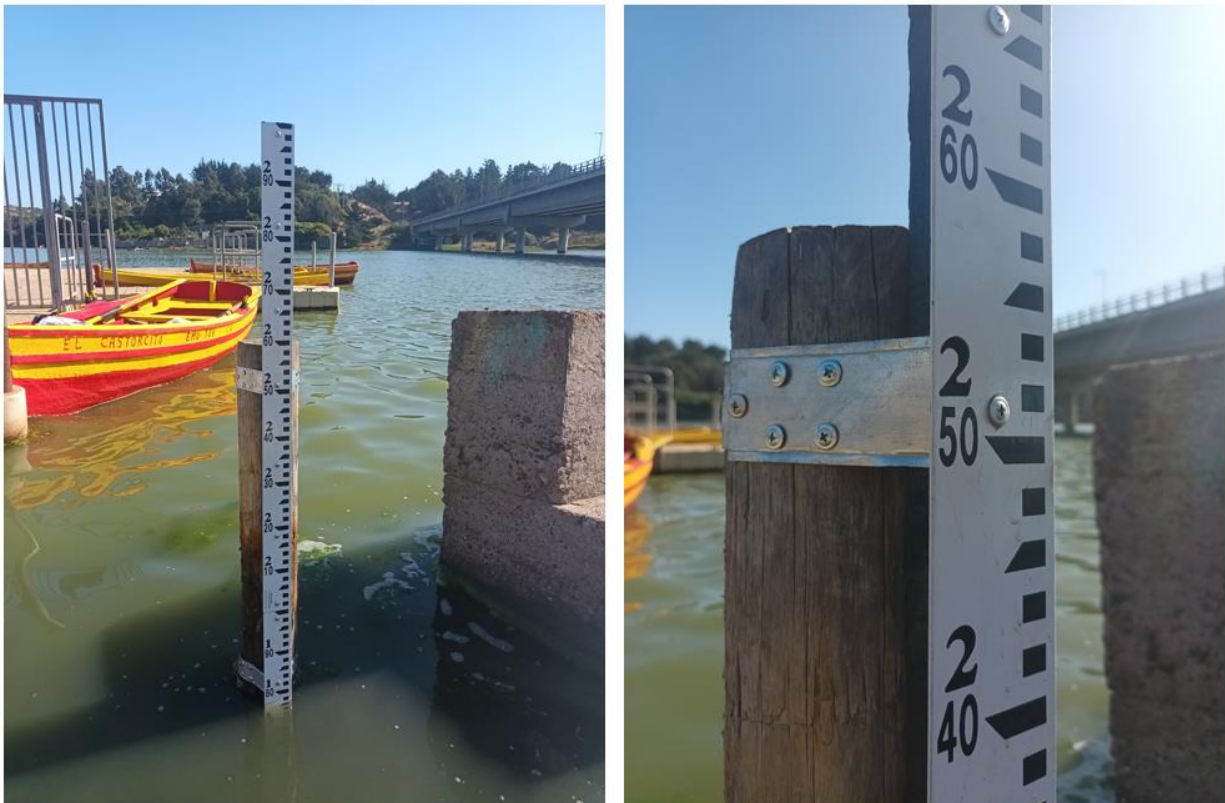
Figura 5 Instalación de regleta de nivel en sector Cáhuil
