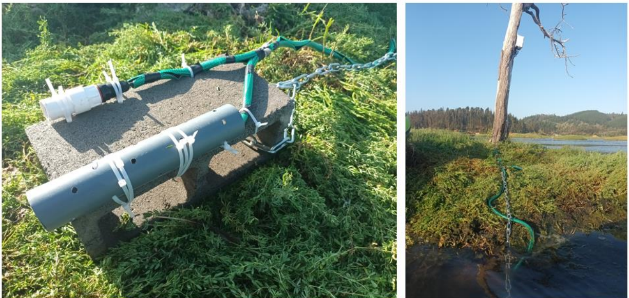
Figura 12 Izquierda: Disposición de sensores de nivel (protegido con tubo PVC gris) y salinidad (protegido con tubo blanco) y detalle de protección de cables con manguera reforzada. Derecha: Bloque de hormigón es sujetado por una cadena amarrada al árbol.
