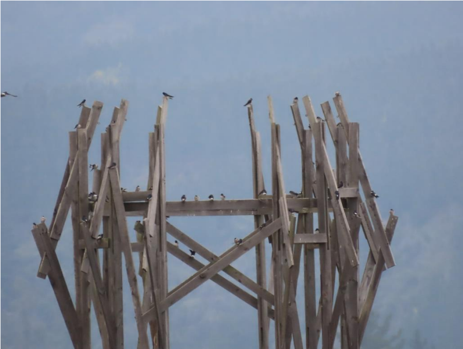
Estructura usada como percha por golondrinas chilenas. Sector de La Villa.
