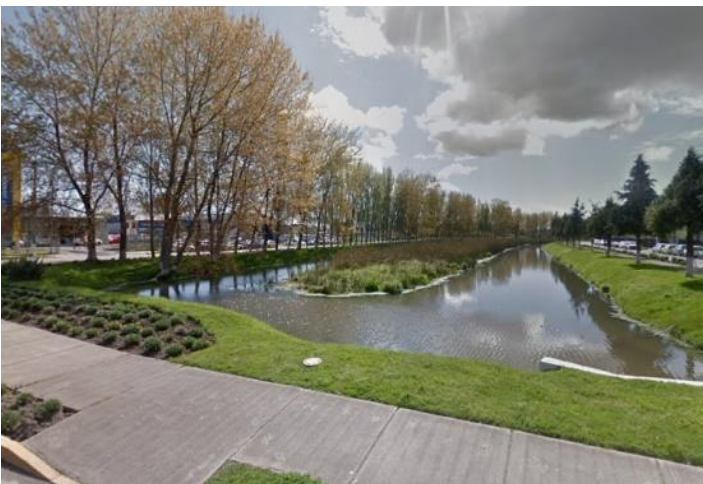
Imagen 12. Canal artificial ubicado a un costado de la Avenida Jorge Alessandri, que conecta con el humedal Paicaví por medio de un ducto ubicado bajo la avenida.
