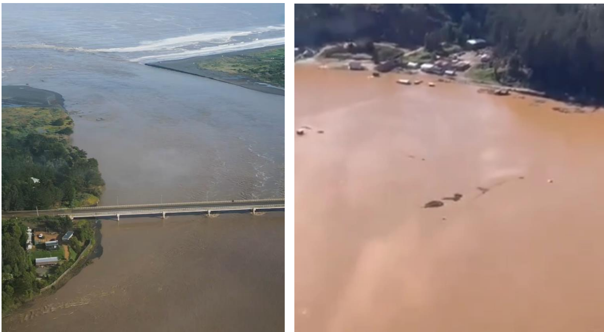
Figura 1 Izquierda: Sector desembocadura de Cáhuil. Derecha: Inundación en sector Barrancas en agosto 2023
